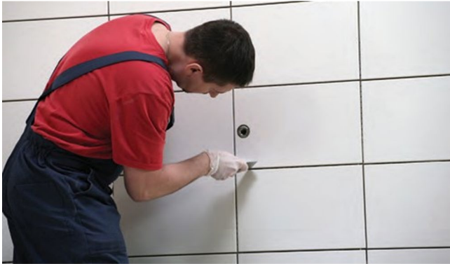
Plaadiservade puhastamine enne vuukimist.
