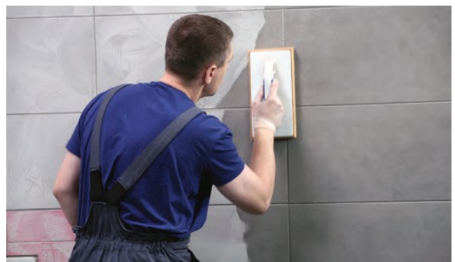
Profileerimise algus on 5–30 minutit.segu pealekandmisest
