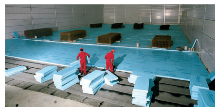
XPS 400 foam plaatide paigaldus külmuhoones
