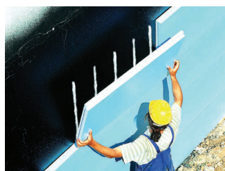
XPS foam plaatide paigaldus keldri seinale polüuretaanliimiga. XPS foam plaatide kasutamine vundamenditõlmiku raketisena kui ka soojustusena
