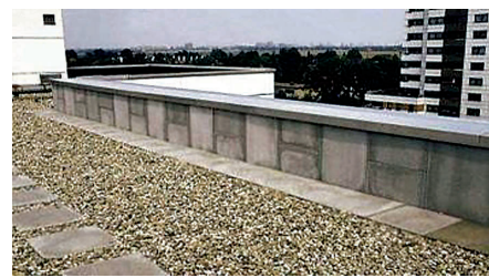
Korterimaja kruusakattega pööratud katuse, käiguteed raudbetoonplaatidest, XPS 250 foam
