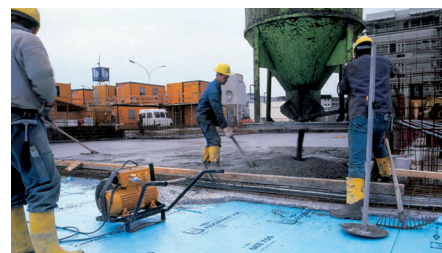
Monoliitse raudbetoonplaadiga kaetud liiklusega koormatud parkimiskatuse, XPS foam 400/500/700
