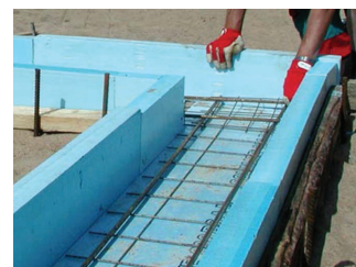
XPS foam plaatide paigaldus keldri seinale polüuretaanliimiga. XPS foam plaatide kasutamine vundamenditõlmiku raketisena kui ka soojustusena
