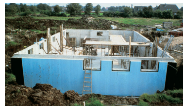
XPS 250 foam SL soojustusplaatide kasutamine keldriseinte soojustamisel
