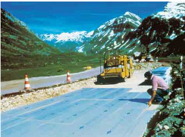
Joonis 15 » Teede kaitsmine külmumise eest tootega STYROFOAM™
