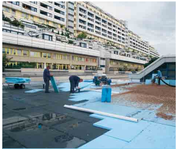
Joonis 71 » STYROFOAM™ soojustuskiht, eralduskiht ja ballast paigaldatakse uuele veekindlale membraanile.
