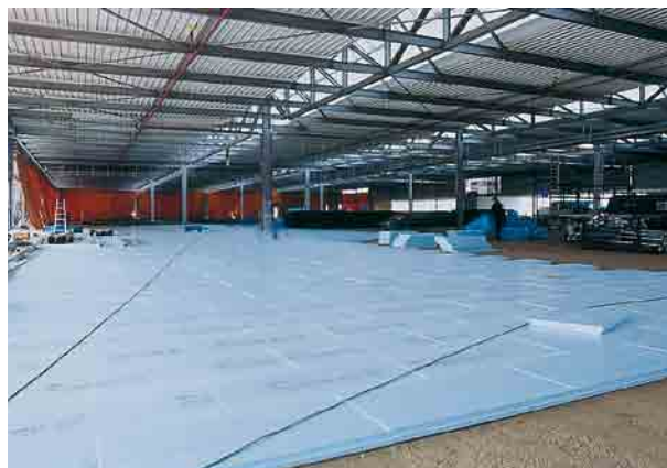
Joonis 13 » Näide põranda pöördisolatsiooni kasutamisest
