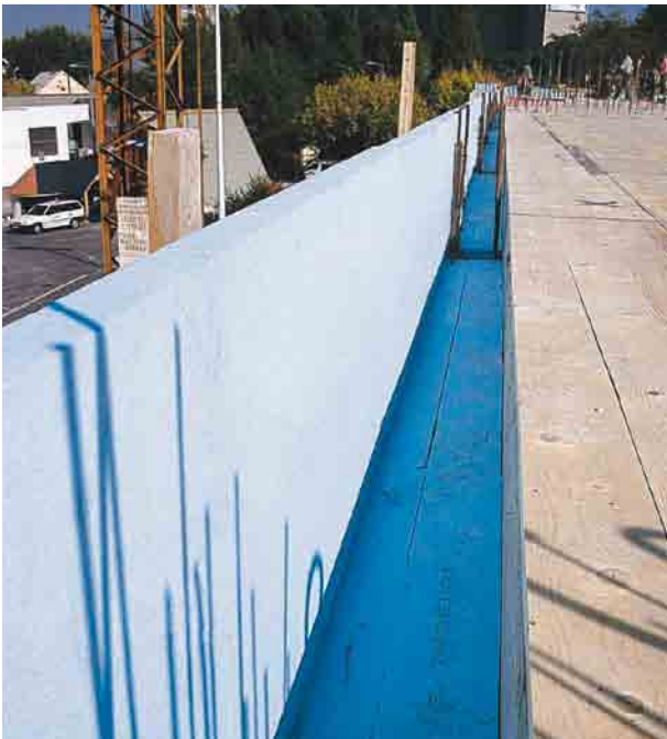
Joonis 78 » Plaatide STYROFOAM™ 300 PL paigaldamine kohtbetooni raketisena
