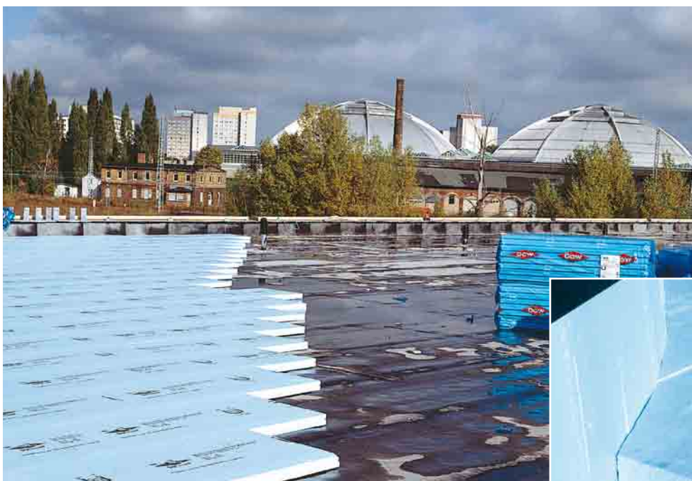
Joonised 52 ja 53 » Tellismüüritse mustri kohaselt lahtiselt paigaldatud STYROFOAM™-plaadid on tihedas sulundühenduses
