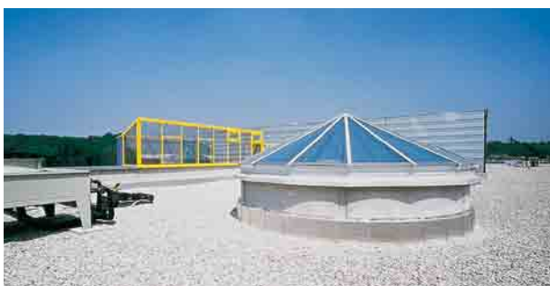
Joonis 55 » Killustikballastiga kaetud katus
