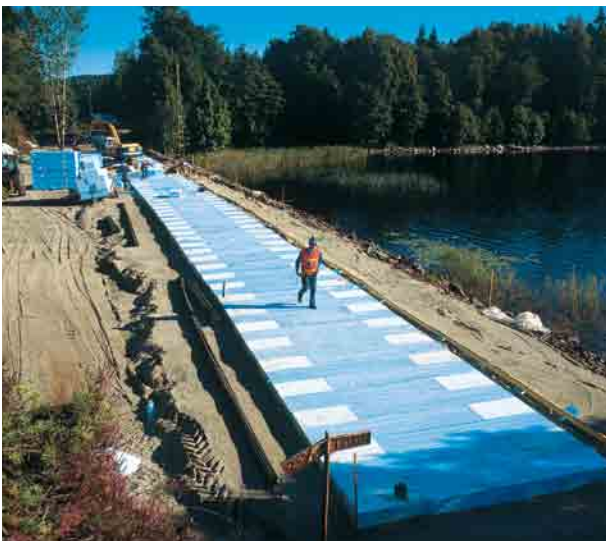
Joonis 16 » Raudteetammi kaitsmine külmumise eest tootega STYROFOAM™
