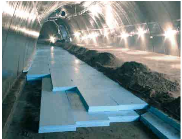
Joonis 48 » Soojustatud tunnel
