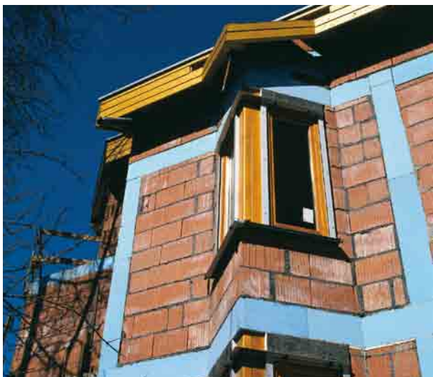
Joonis 74 » Materjaliga STYROFOAM™ 300 PL soojustatud kylmasillad
