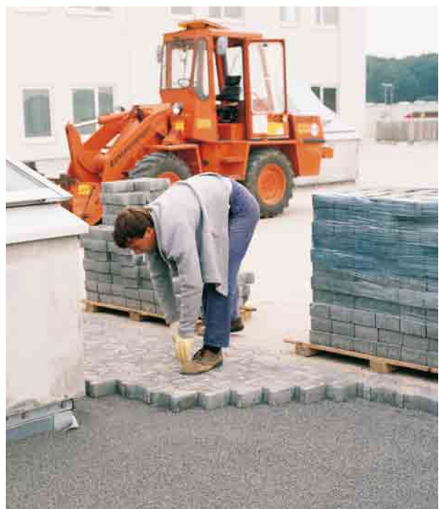
Joonis 66 » Servasoonega R/B sillutiskivide paigaldamine purustatud kruusast padjale
