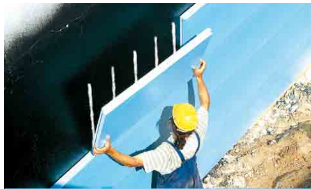
Joonis 08 » Kasutades INSTA-STIK™ liimi STYROFOAM™ plaatidega perimeetrilise soojustusvöö tegemine
