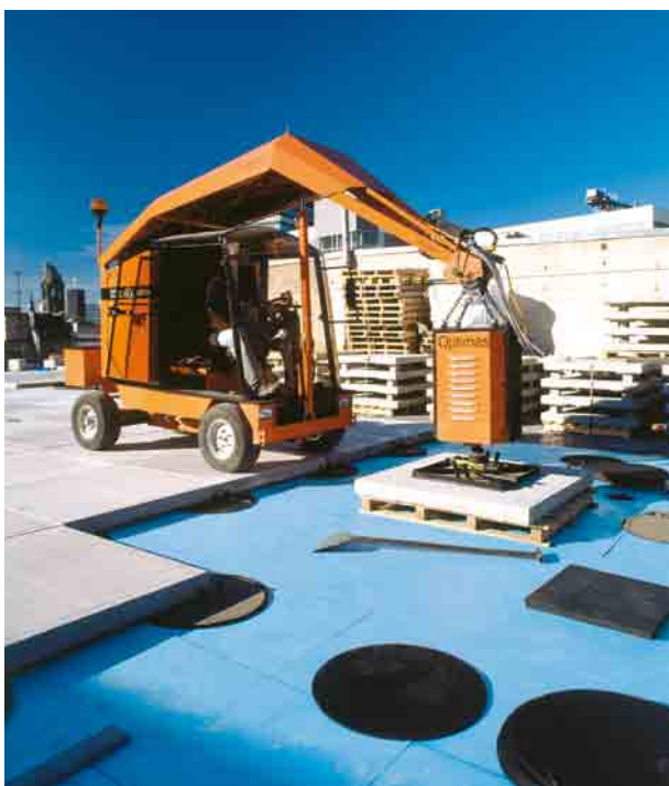
Joonis 65 » Monteeritavate raudbetoonpaneelide automatiseeritud paigaldamine distantspuksidele
