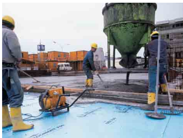
Joonis 14 » STYROFOAMi™ mehaaniline tugevus raudbetooni paigaldamisel
