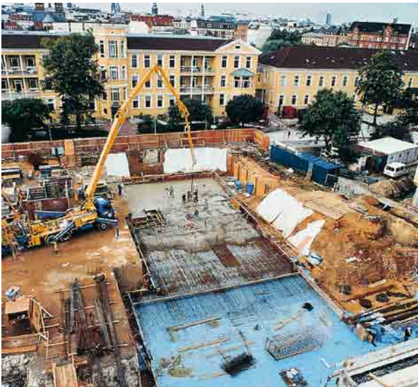
Joonis 10 » STYROFOAM™-ist soojustus kandetarindplaatide all
