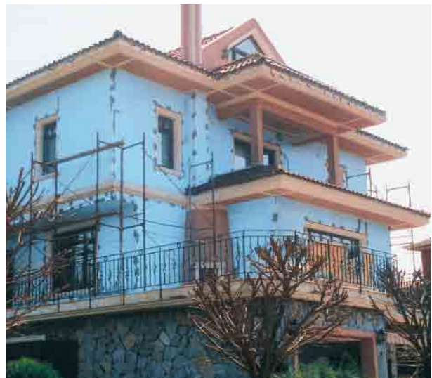
Joonis 81 » Välisseina soojustamine STYROFOAM™ 300 PL plaatidega
