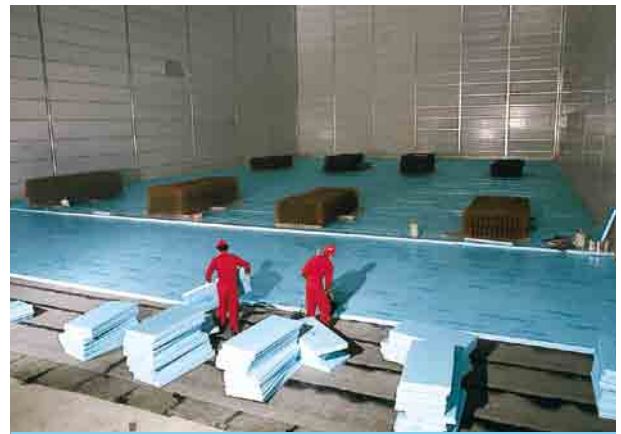
Joonis 85. Külmlao põranda isoleerimine STYROFOAMi™ plaatidega.
