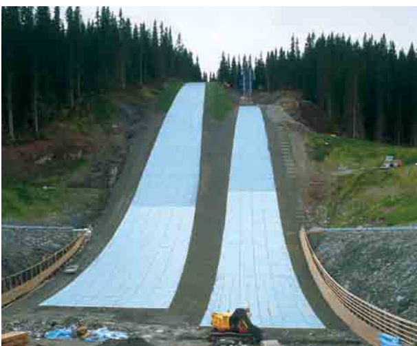
Joonis 17 » Suusanõlvade lihtne ja kuluefektiivne isoleerimine külmakergete eest
