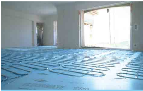
Joonis 12 » Vahetult soojustuskihile või membraanile paigaldatud põrandaküttestorustik
