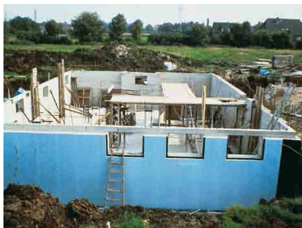
Joonis 05 » Keldriseinte väline soojustus koos täielikult kaitstud veekindla membraani kasutamisega
