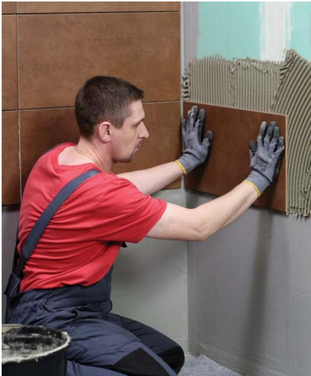
4 tunni pärast võib hakata plaate kinnitama.
