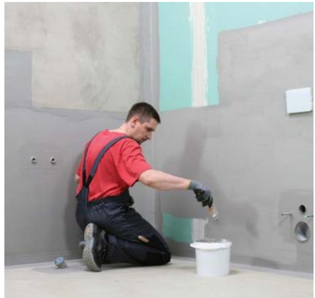
Esimese ja teise isolatsioonikihi pealekandmine pintsliga.
