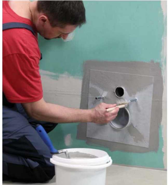
Tihenduslindi või tehnilise vaheriide kleepimine (ruutmeetrikaal max 60 g/m 2 ) toruläbiviikudele
