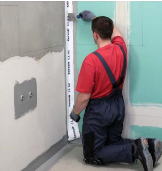
Tihenduslindi CL 152 kleepimine vertikaalnurkadesse
